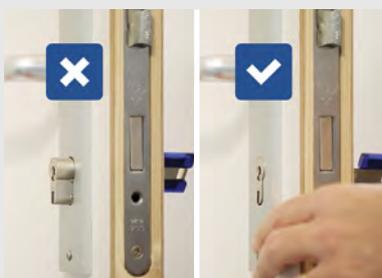
Le cylindre ne doit pas dépasser de l'autre côté de la porte afin de mieux résister aux tentatives d'effraction.
